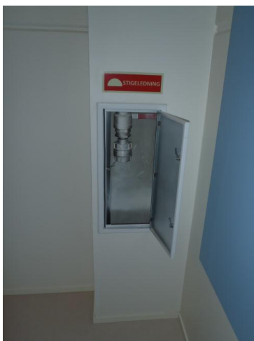
Feil plassering av uttak og påkoblinger.
