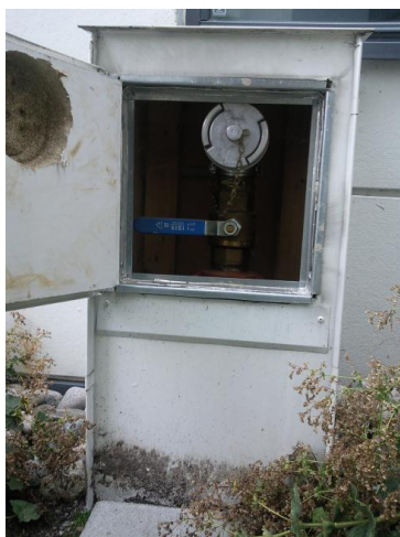
Feil plassering av uttak og påkoblinger.
