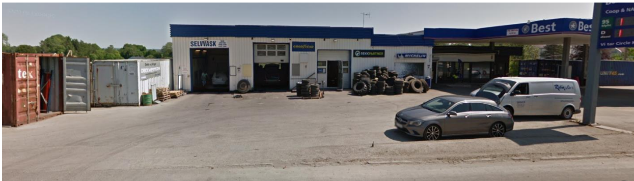
Foto fra Google Street View, med omsøkt plassering av handelslokale innenfor lagerport 2 halvåpen midt i bildet.
